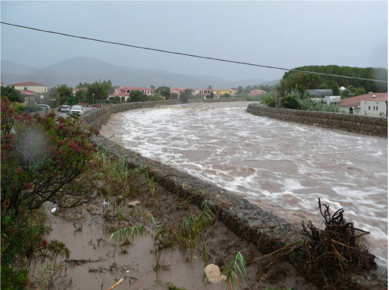
Il Rio San Teodoro a monte del ponte lungo Viale Sardegna nel corso dell'evento del 24/09/2012
